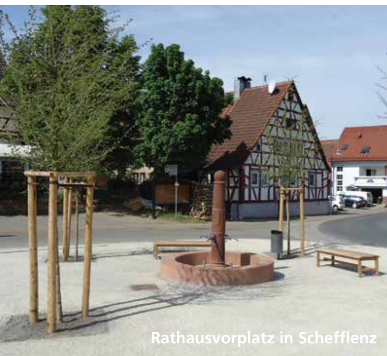
Ausbau der Schulstraße in Oedheim
